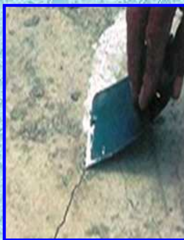
Sellado grietas y huecos
