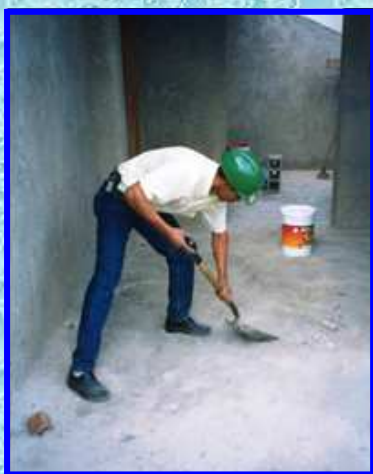
Preparación de la losa
