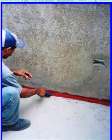
Aplicación en zonas críticas
