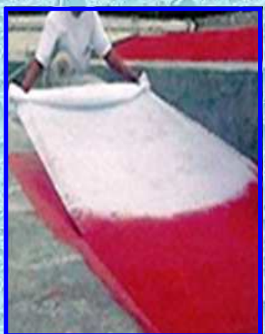
Colocación tela refuerzo
